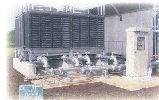
《小学校工事中の一例》
